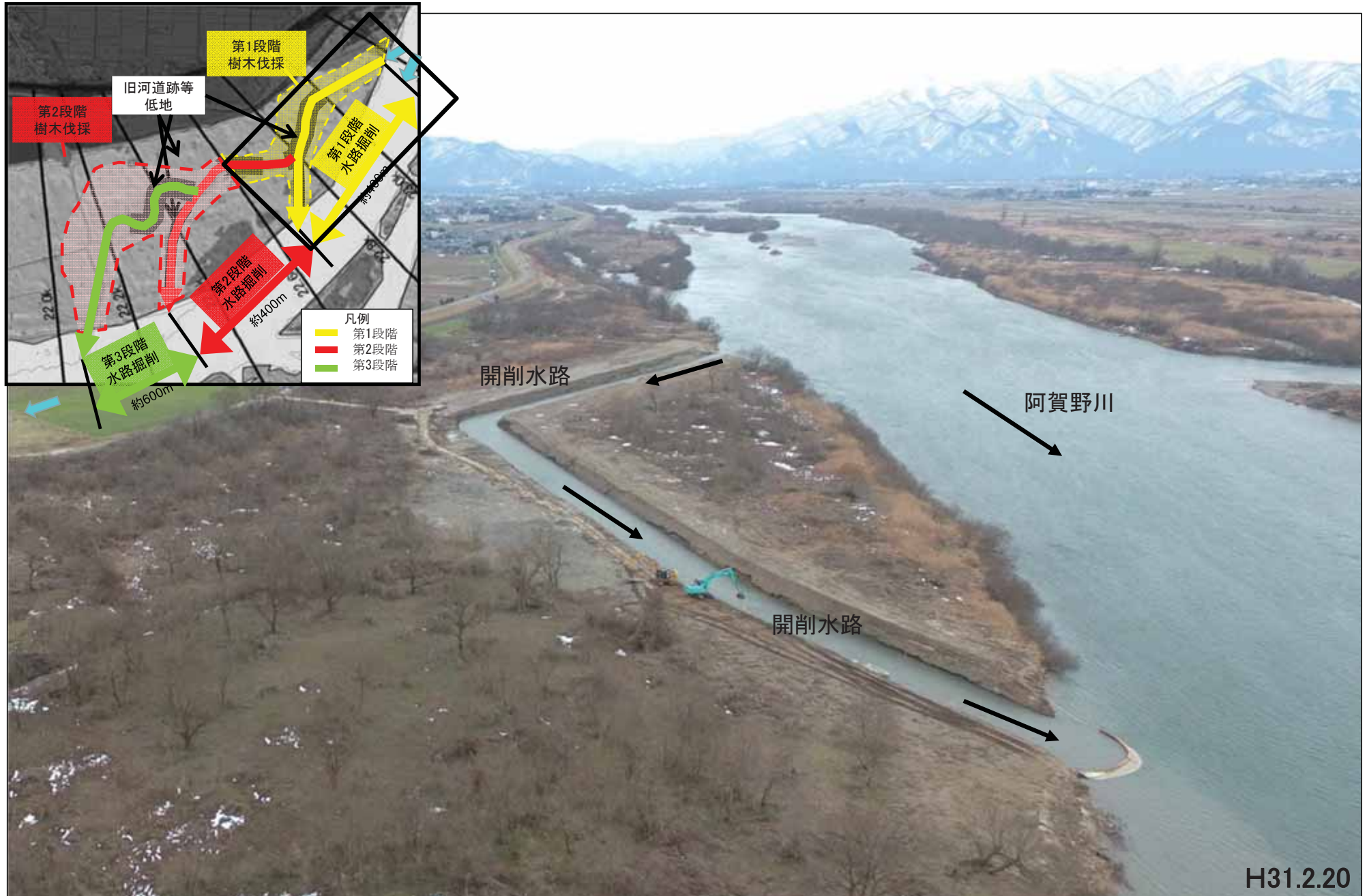
水ヶ曽根地区 工事状況
