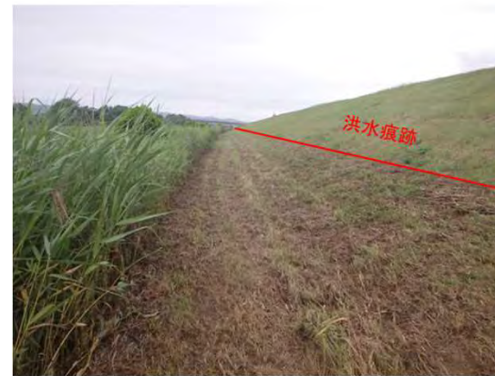
水制工施工付近の洪水痕跡
