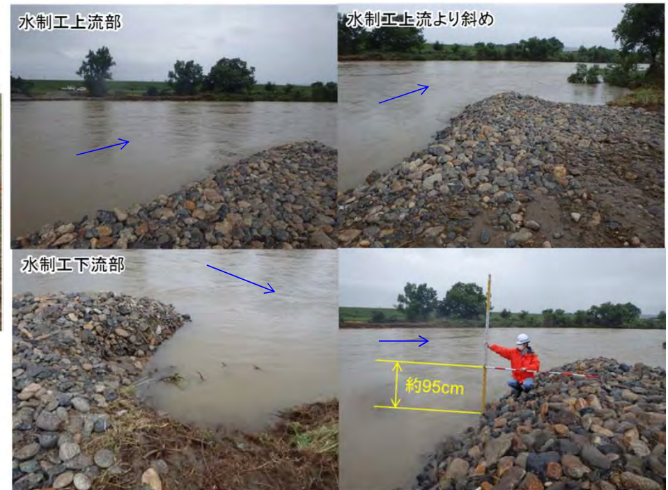
No.37水制工(右岸)の状況 (7月7日撮影)
