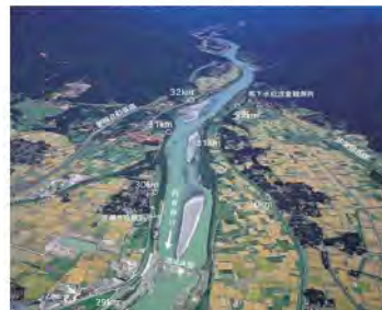
渡場床固工〜馬下頭首工付近
