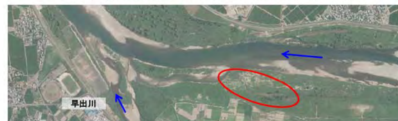
図 4.4-3 対策の実施箇所（阿賀野川 高山地区: 23.1～23.6k 左岸）
