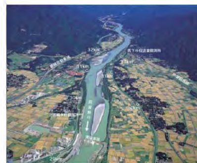
写真 1.4-1 渡床床固付近(阿賀野川 29k~30k)
