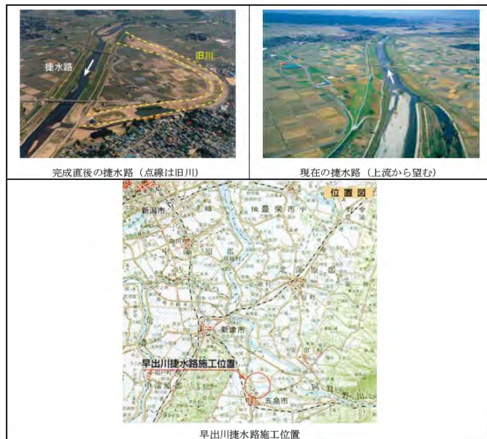
図 1.6-2 早出川捷水路の改修状況
