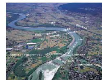
沢海床固工付近
