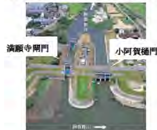
写真 3.2-10 小阿賀樋門及び満願寺開門
