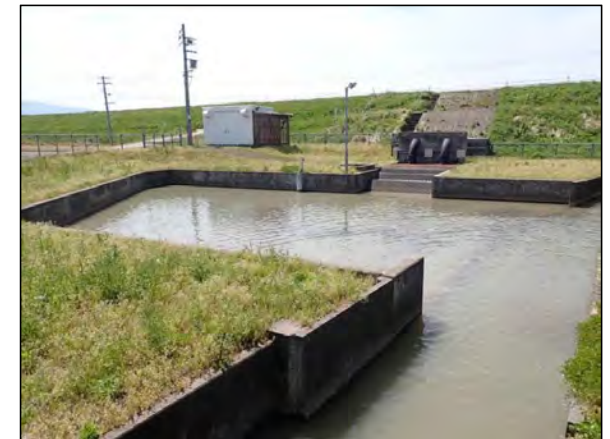
堤内の排水機場
