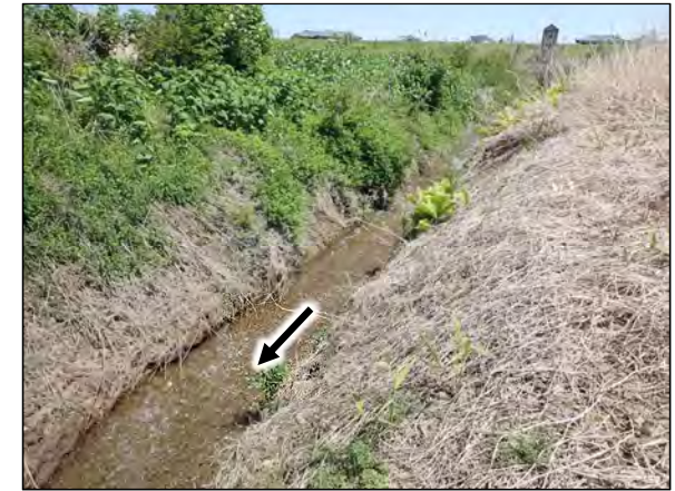
樋管下流側の水路
