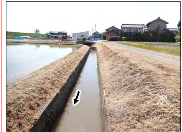
樋管上流側(堤内)の水路
