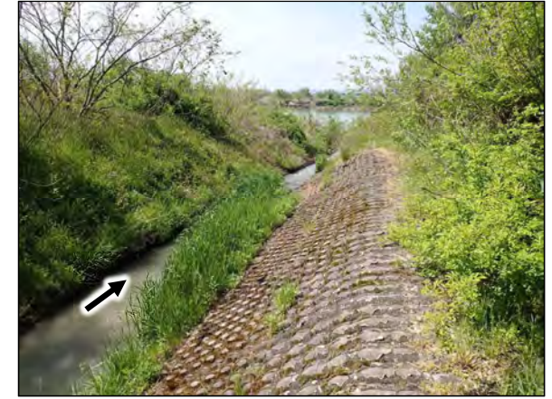
樋管下流側の水路
