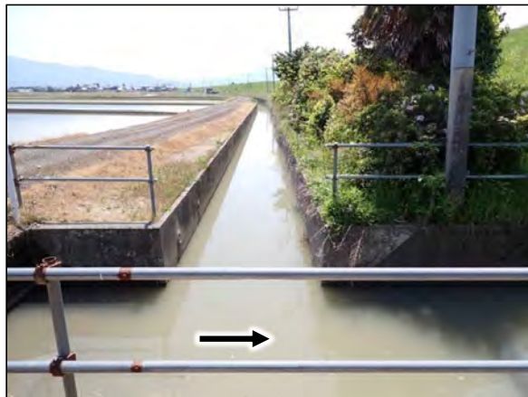
樋管上流側の水路
