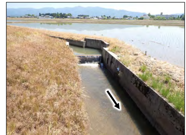
堤内の落差(水田への取水)
