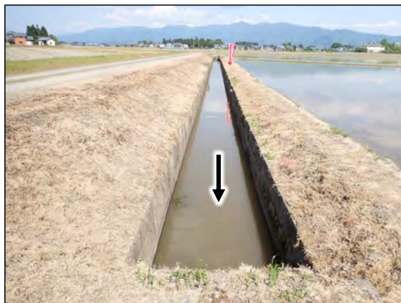
樋管上流側(堤内)の水路
