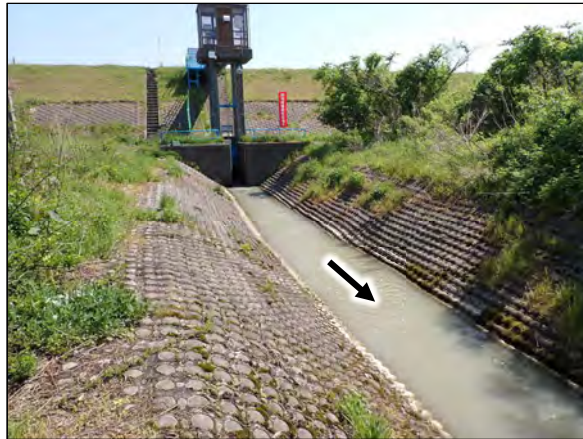
樋管下流側の水路
