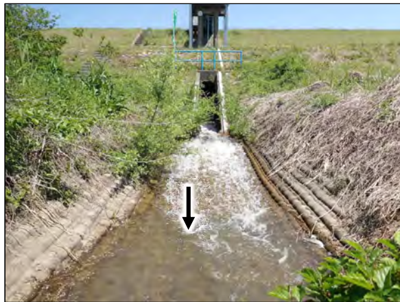
樋管下流側の水路
