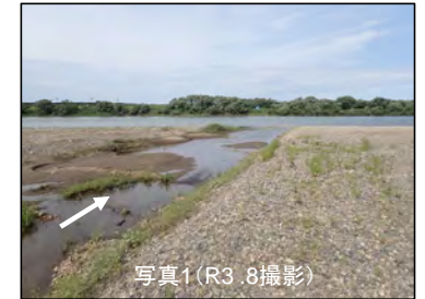
出水後水路状況
