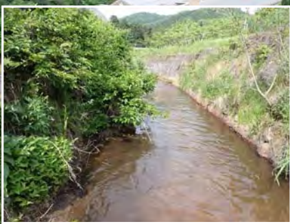
堤内水路は、三面張りのコンクリートブロックで囲まれている
