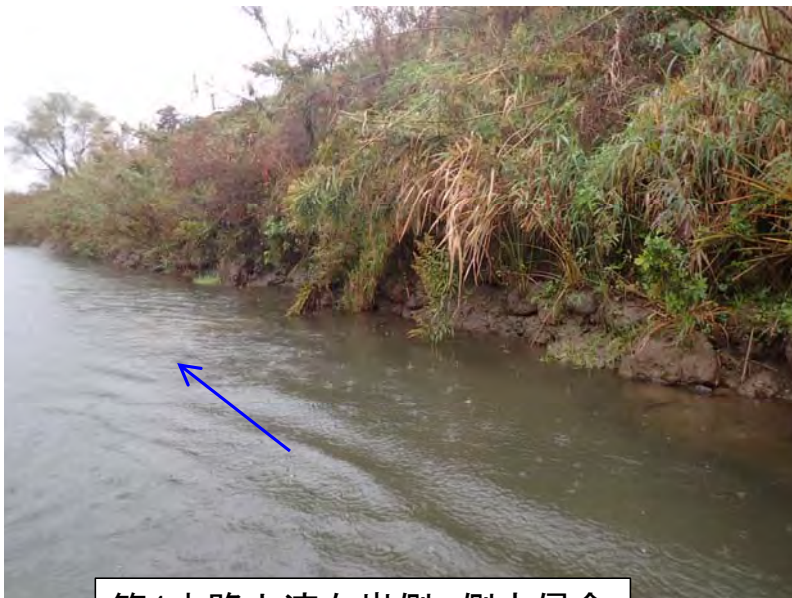
第1水路上流右岸側 側方侵食
