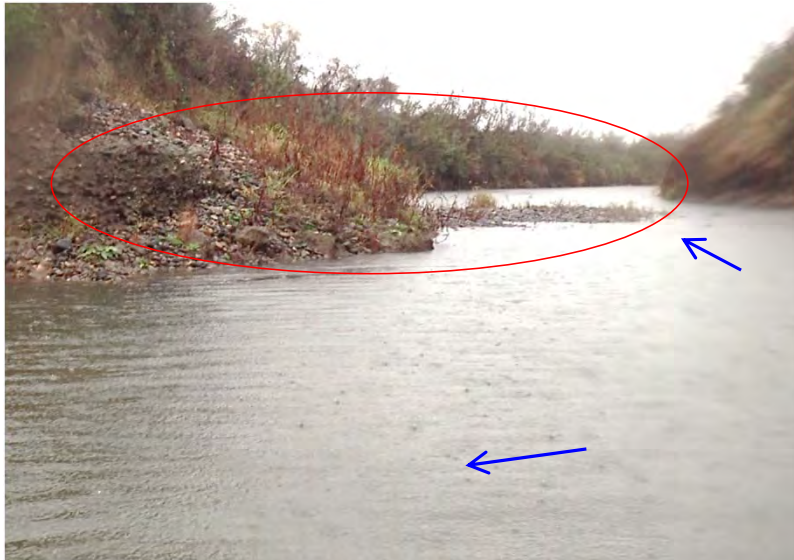
第1水路と第2水路分岐点、左岸側礫河原の形成
