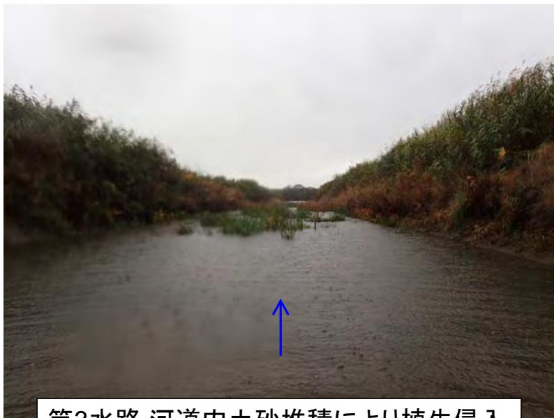
第3水路 河道内土砂堆積により植生侵入
