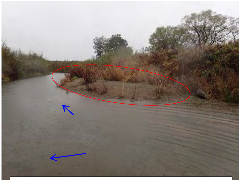
第2水路と第3水路分岐点、右岸側土砂堆積
