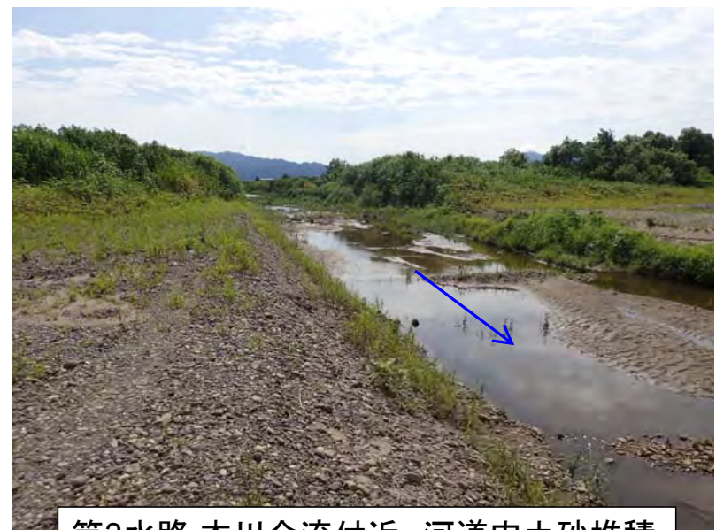
第3水路 本川合流付近 河道内土砂堆積
