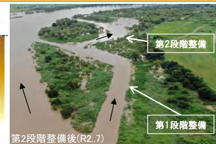
図2 砂礫河原の再生工法及び再生状況
