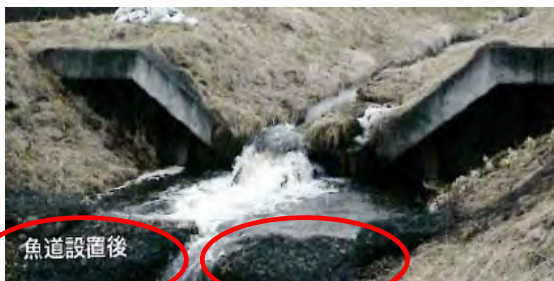
図 現地材料を用いた簡易な魚道の設置例 例、北海道駒生（こまおい）川 出典：『水辺の小さな自然再生事例集第2集』、2020.3
