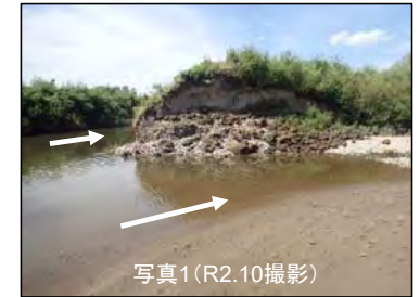
出水後水路状況
