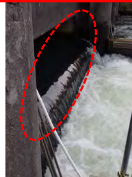
隔壁上段の越流状況
