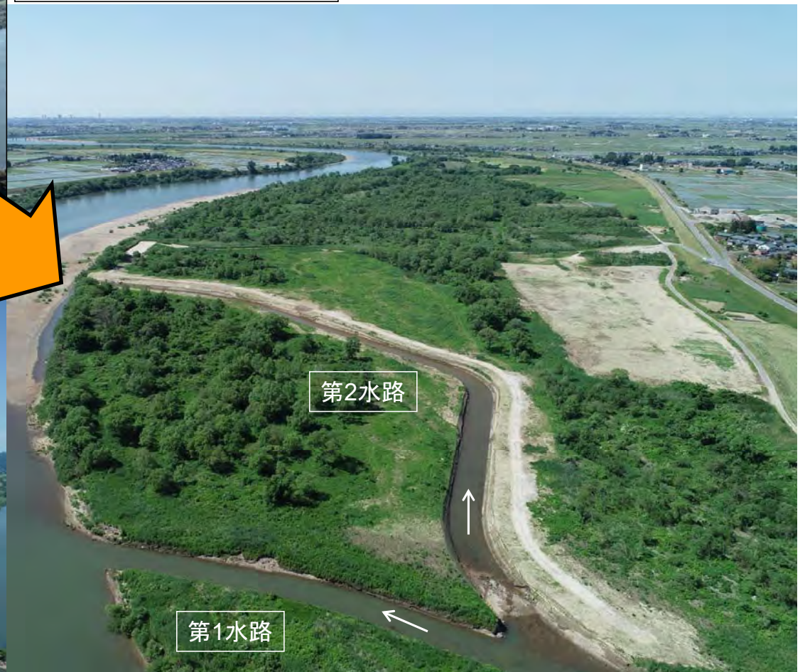
R2.5.22 第2水路施工直後
