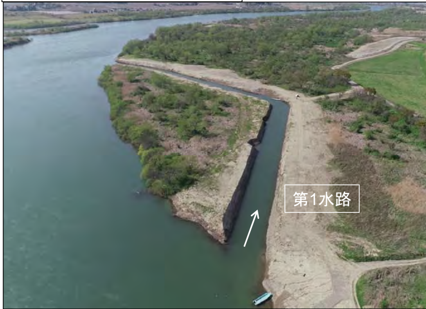
第1水路整備直後 H31.4.22
