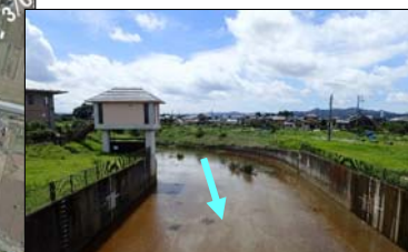
⑨太田川：堤内の水路
