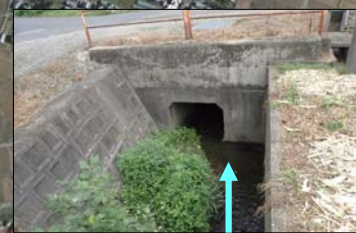
⑥三本木排水樋管:堤内の水路
