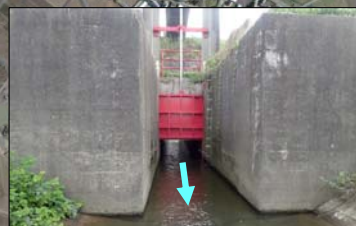
④向島排水樋管:樋管の出口
