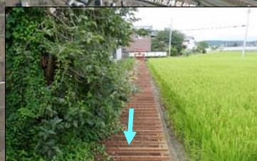
②下条排水樋管:堤内の水路
