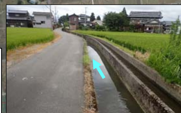
③下条排水樋管:堤内の水路
