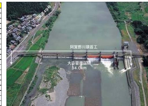
阿賀野川頭首工
