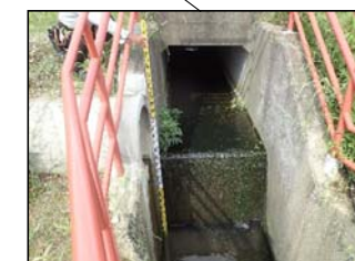
下条排水樋管に繋がる水路の落差(1.77k)
