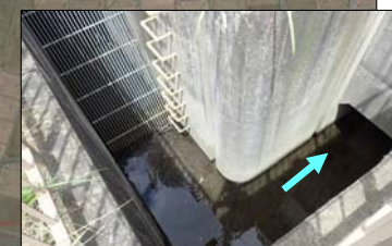
⑦三本木排水樋管:堤内の水路
