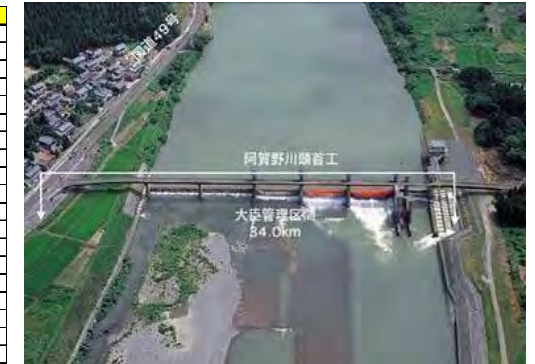
阿賀野川頭首工
