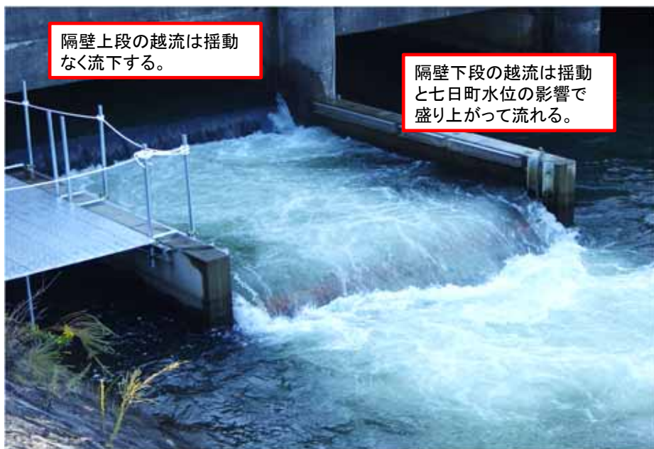
写真 隔壁上下段の越流状況
