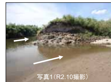
出水後水路状況
