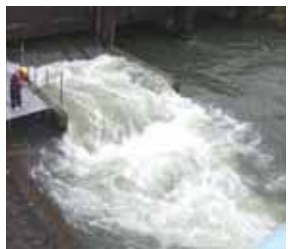
写真 魚道内流況(流量:約5.8m³/s)
