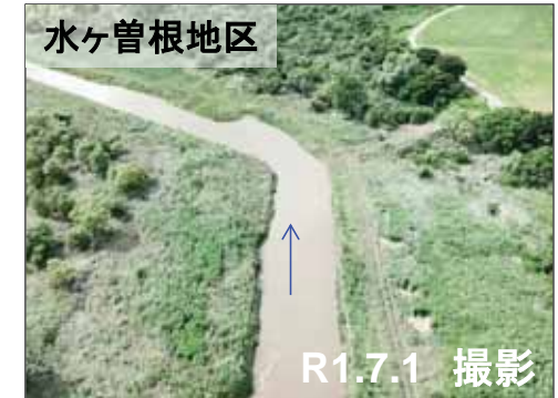
梅雨期出水後の状況
