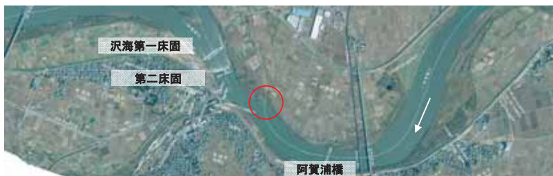
図 4.5-11 対策の実施箇所（改修事業：満願寺地区：17.0～17.4k 右岸）
