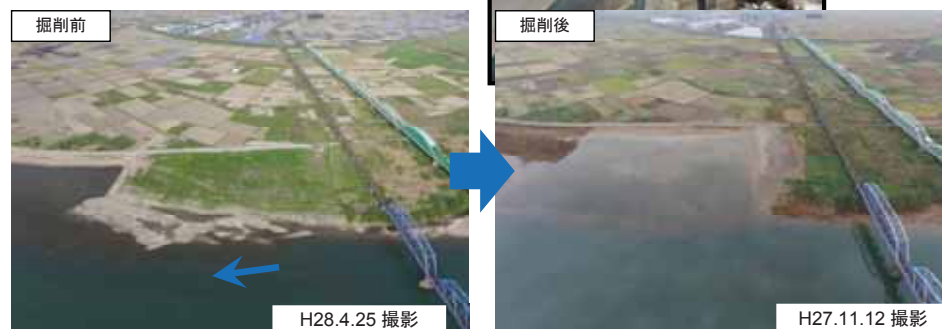
写真 4.5-1 下里地区の河道掘削状況
