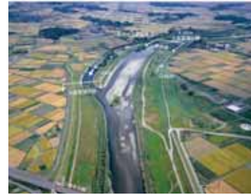
三本木大橋～善願橋付近
