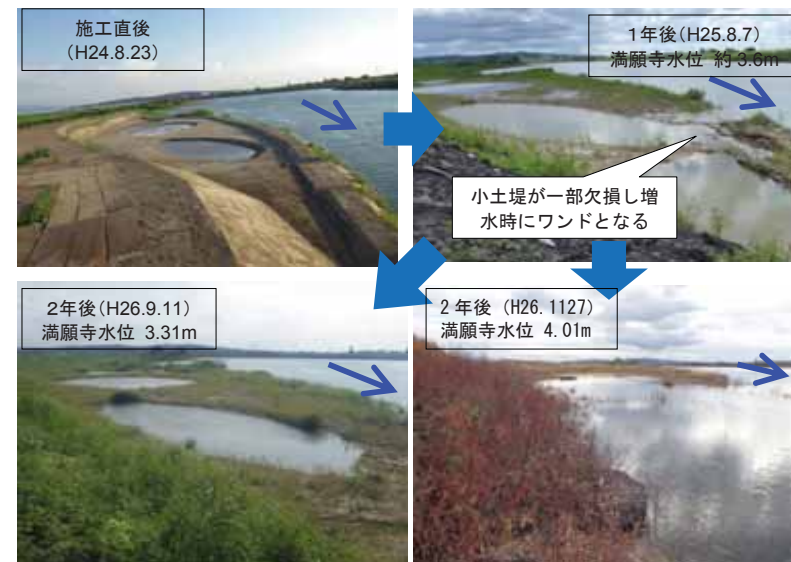
写真 4.5-2 満願寺地区の整備後状況
