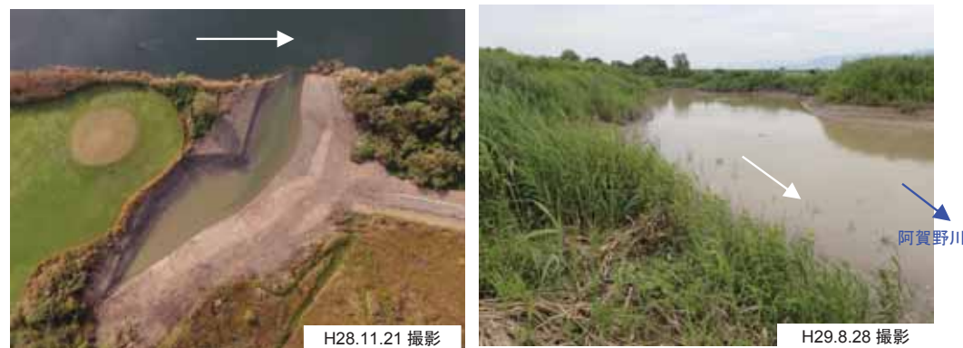
写真 4.4-8 下里地区上ワンドの整備直後の写真
