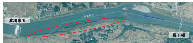
図 4.5-4 対策の実施箇所(改修事業：笹堀地区：29.4～31.5k 左岸)
