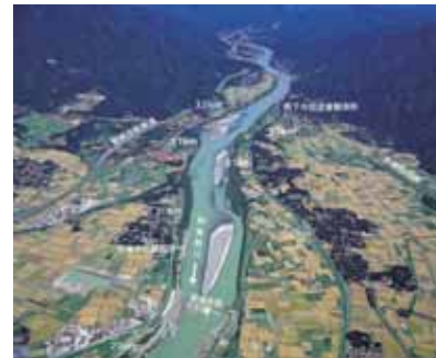
写真 1.4-1 渡場床固付近(阿賀野川 29k~30k)
