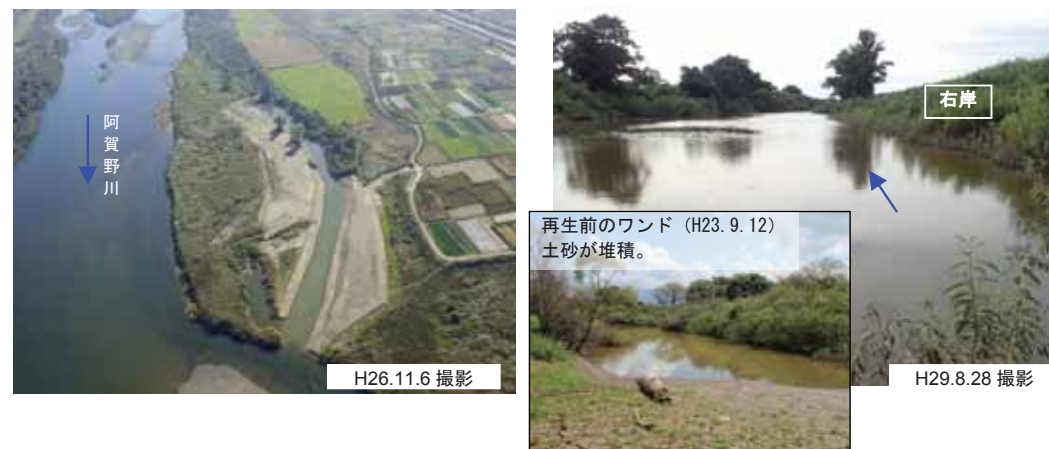
写真 4.4-4 高山地区ワンドの整備直後の写真
