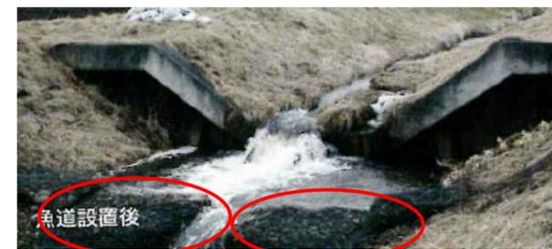
図 5.6-2 現地材料を用いた簡易な魚道の設置例、北海道駒生（こまおい）川
