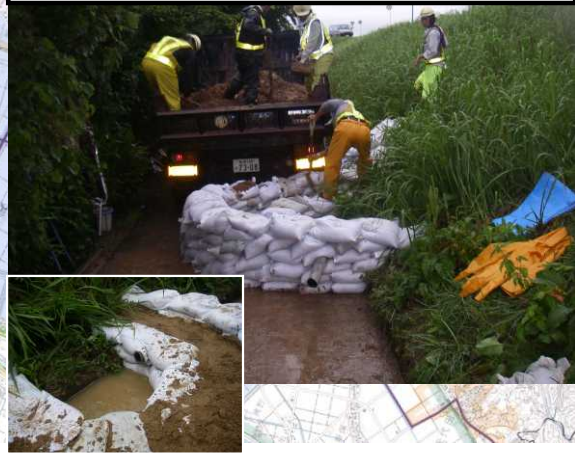
②嘉瀬島地先 堤防漏水、月の輪対応中
