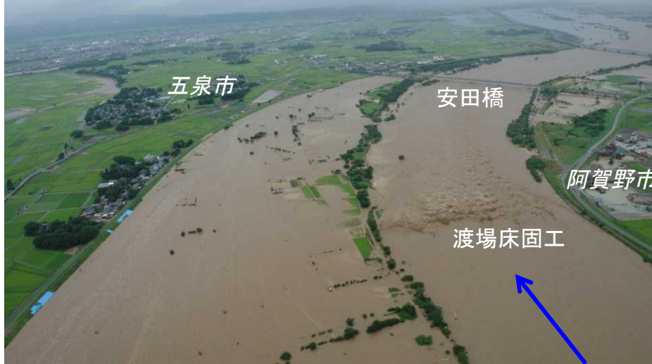
平成23年7月30日出水写真（阿賀野市渡場地先）
