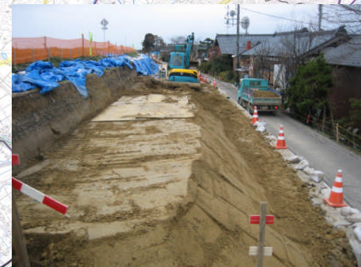
②H24. 12末 堤防川裏亀裂切返し埋戻し土砂施工中
