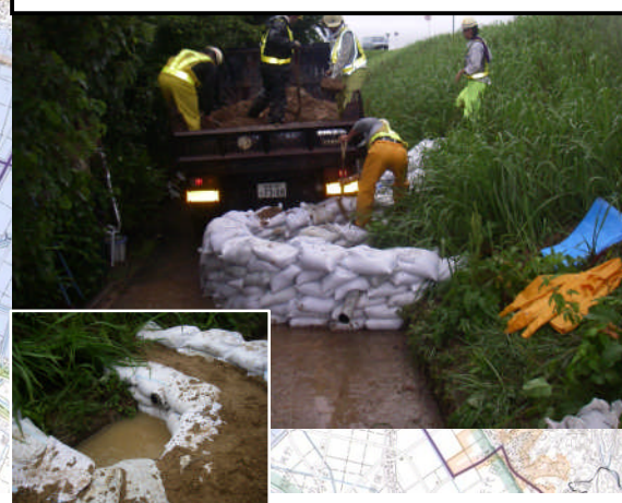
②嘉瀬島地先 堤防漏水、月の輪対応中
