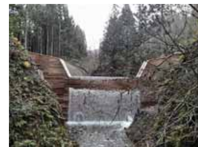
【治山:溪間工(治山ダム)】
