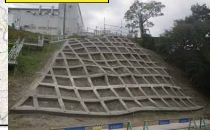
急傾斜地崩壊対策
