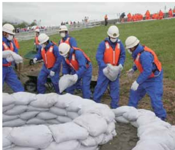
消防団による水防工法訓練（釜段工） 資料-5-13
