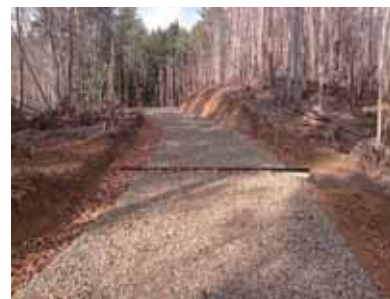
【森林整備:林道(整備)】
