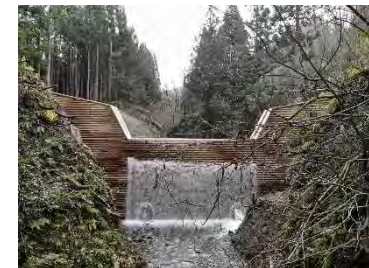
【治山:溪間工(治山ダム)】
