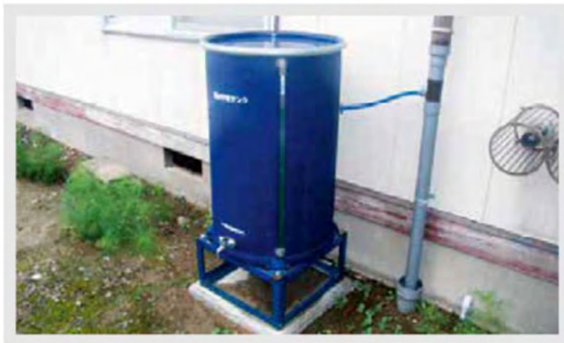
【貯留タンク設置例】
