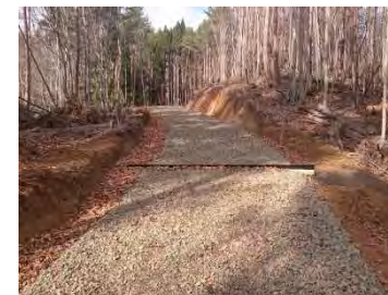
【森林整備:林道(整備)】
