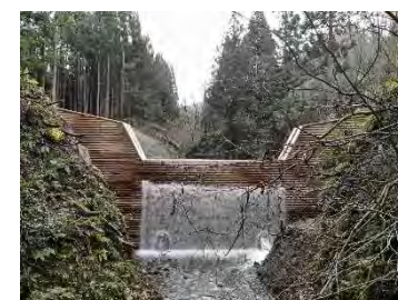
【治山:溪間工(治山ダム)】
