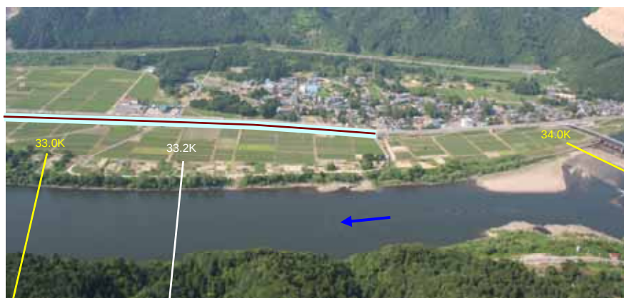
図 II-6 小松地区② 無堤区間
