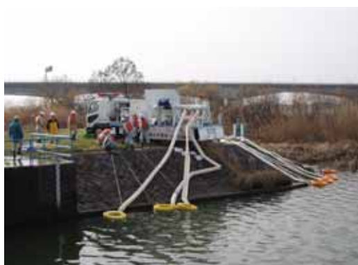
図 II-26 排水ポンプ車操作訓練
