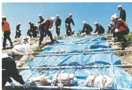
図 II-63 シート張り工
