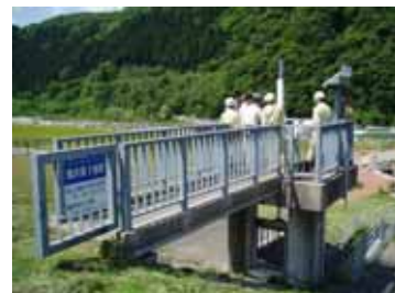
図 II-45 河川管理施設の点検
