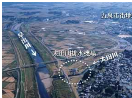
図 II-27 太田川排水機場付近
