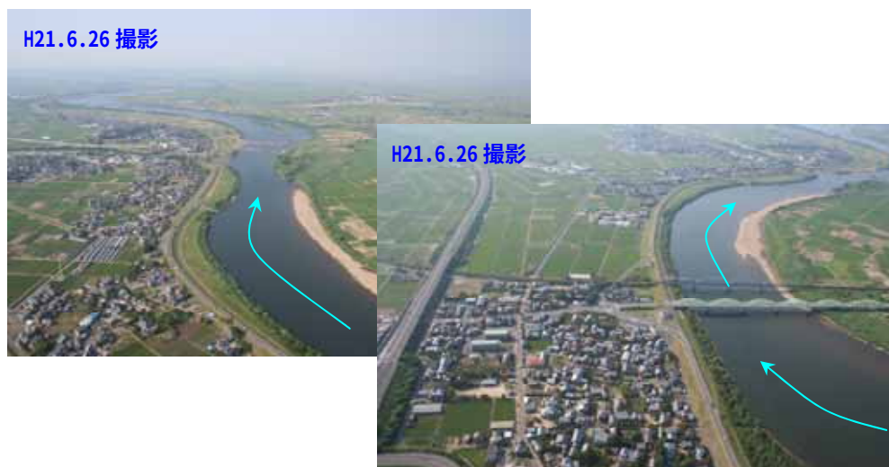
図 II-23 中新田地区水衝部の状況
