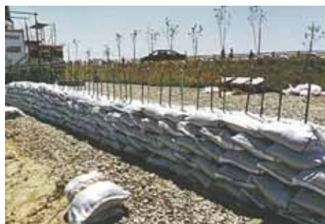
図 II-61 積み土のう工
