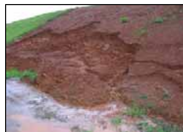
図 II-43 堤防の損傷
