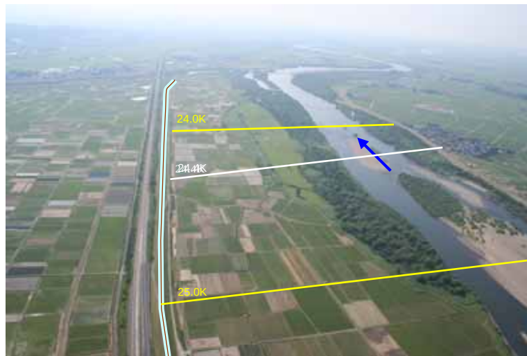
図 II-4 高山地区 弱小堤区間
