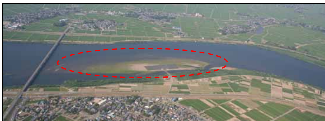
図 II-42 堆積土砂の除去
