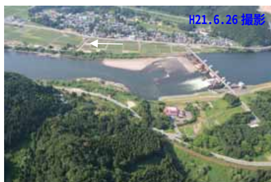
阿賀野川頭首工
