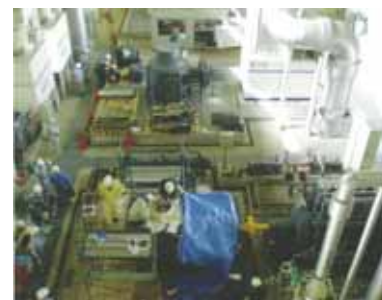
図 II-46 胡桃山排水機場におけるポンプ点検作業
