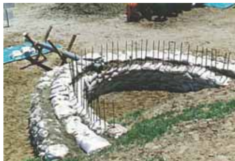
図 II-64 月の輪工
