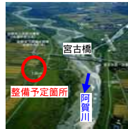
防災ステーション予定箇所
