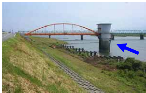
左岸14k付近低水護岸 施工前
