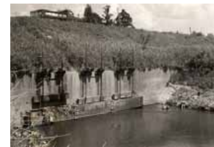
旧小阿賀樋門（第一期改修）
