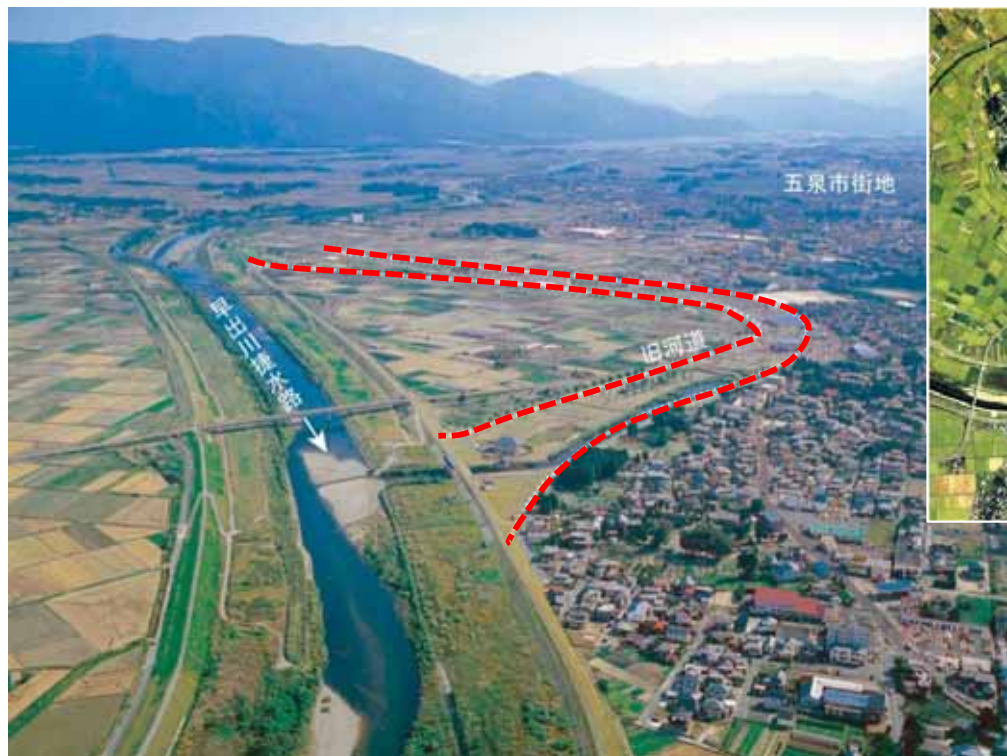
早出川捷水路
