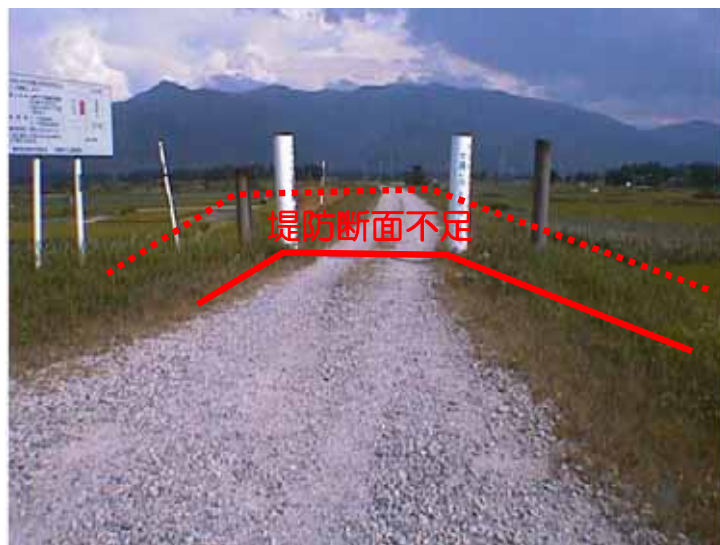
阿賀野川左岸笹堀地区
