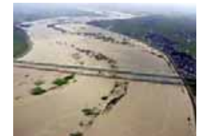
JR羽越本線阿賀野川橋梁、
