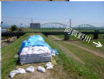
水防資材を近傍に常備
