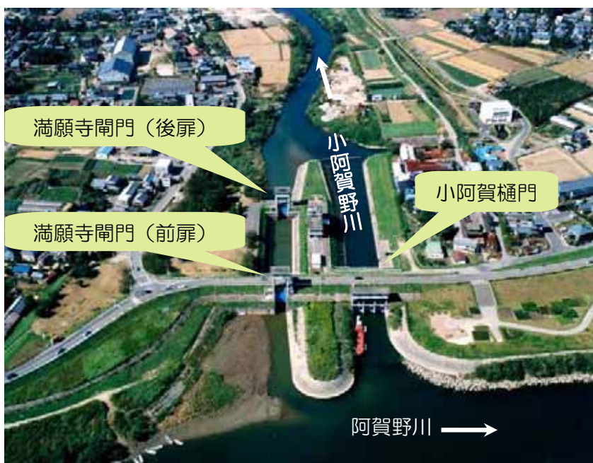
現在の満願寺閘門と小阿賀樋門
