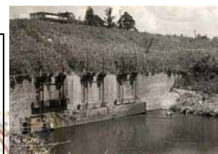
旧小阿賀樋門 （第一期改修）
