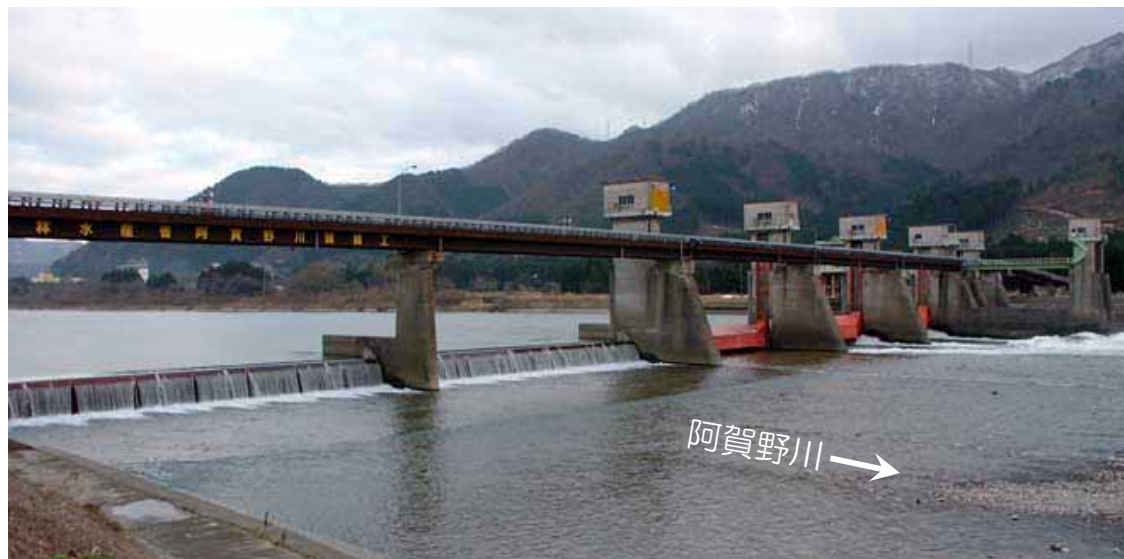
阿賀野川頭首工
