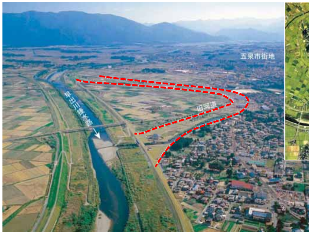
早出川捷水路
