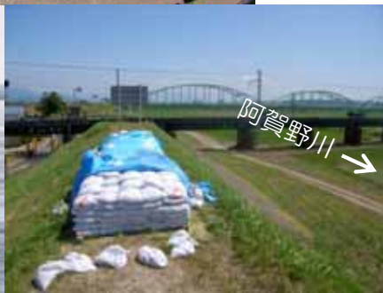
水防資材を近傍に常備
