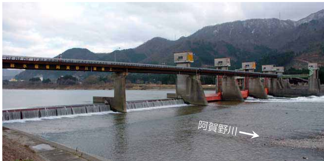
阿賀野川頭首工
