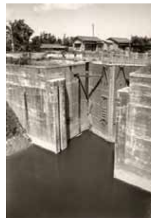
旧満願寺閘門（第一期改修）
