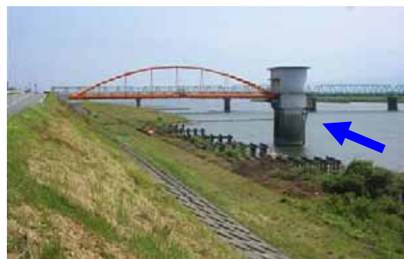
左岸14k付近低水護岸 施工前
