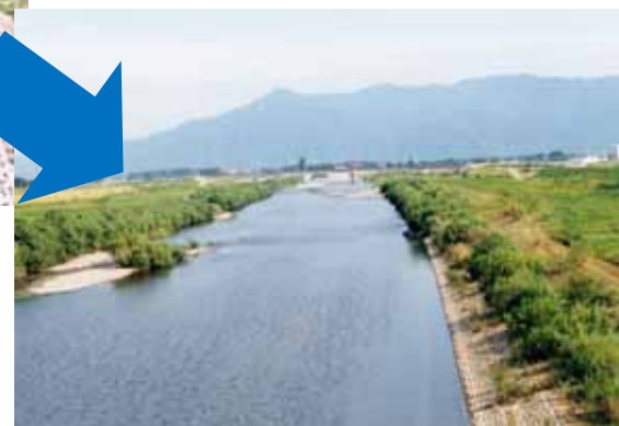
豊かな自然が回復した捷水路（H12撮影）
