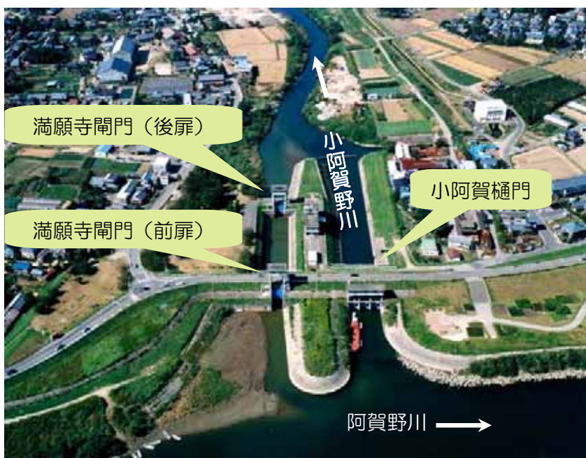
現在の満願寺閘門と小阿賀樋門
