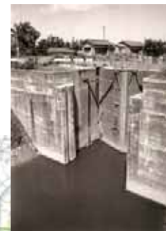
旧満願寺閘門 （第一期改修）
