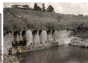
旧小阿賀樋門 （第一期改修）
