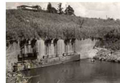
旧小阿賀樋門（第一期改修）
