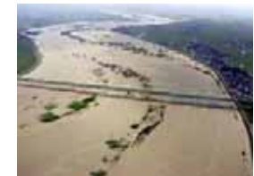
JR羽越本線阿賀野川橋梁、
