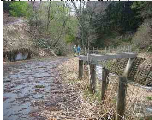
砂防設備点検状況 (馬取川第2号砂防えん堤)
