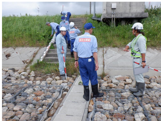
令和6年度の点検状況
