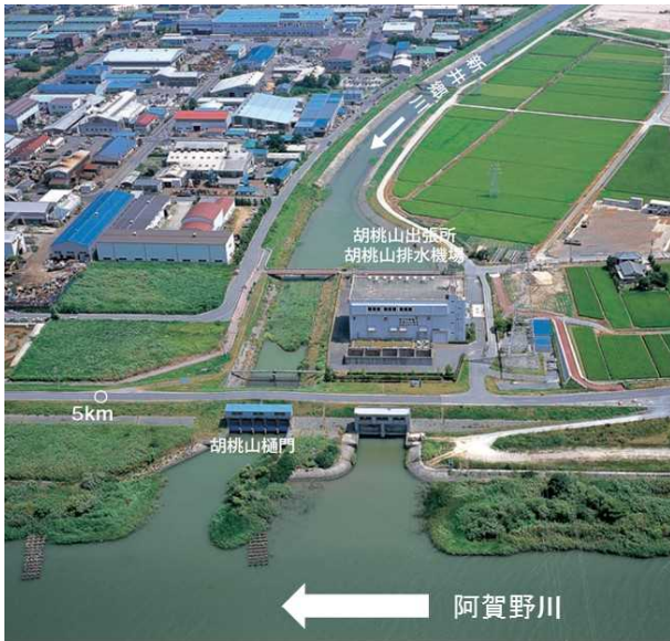
胡桃山排水機場 (阿賀野川河川事務所・胡桃山出張所)
