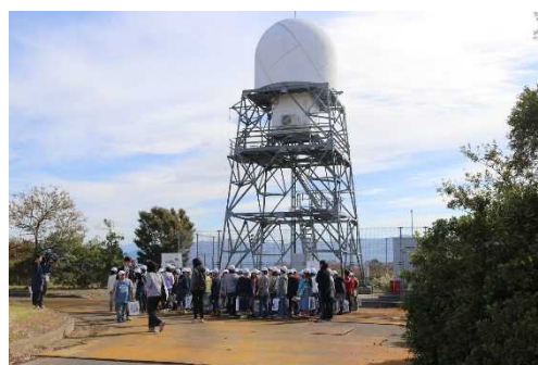
阿賀野川きょうがせ防災ステーション Xバンドレーダ
