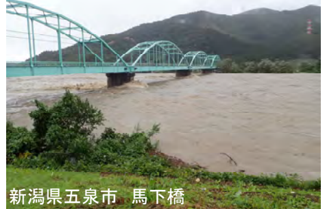
新潟県五泉市 馬下橋
