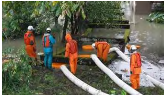
排水ポンプ車による排水作業：10月13日5時40分～12時35分
