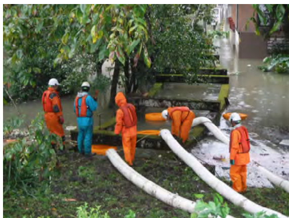
排水ポンプ車による排水作業：10月13日5時40分～12時35分
