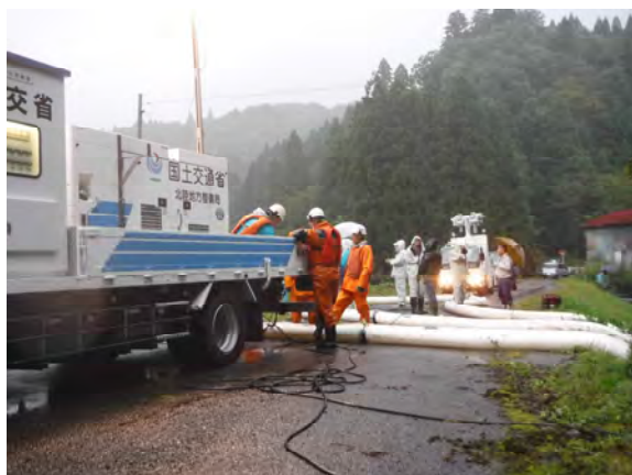
排水ポンプ車による排水作業：10月13日5時40分～12時35分
