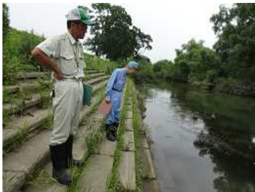
前回の点検実施状況(河川)
