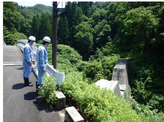
前回の点検実施状況(砂防)
