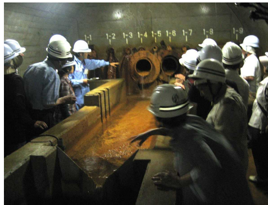
排水トンネルの視察
