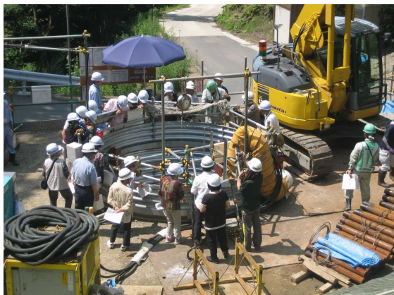
しゅうすいせい 集水井（地下水を集める井戸）の視察
