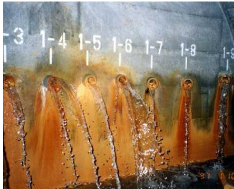
袖の沢地区 集水ボーリング施工状況
