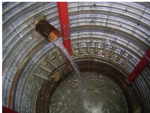
松坂地区 集水井施工状況
