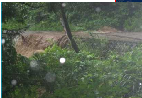
県道寸断により一時上流で孤立化
