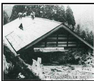
昭和42年8月羽越災害時に軒下まで流出土砂に埋没した家屋
