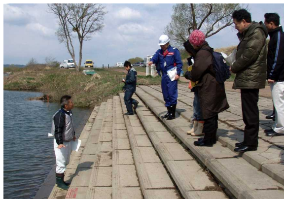
平成25年の点検時の状況 （点検箇所：大和水辺の楽校）
