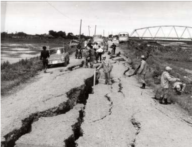
新潟地震における被害状況（津島屋）
