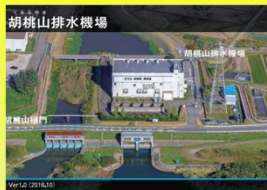
胡桃山排水機場
