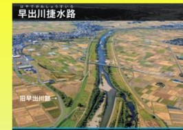
早出川捷水路
