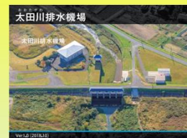
太田川排水機場
