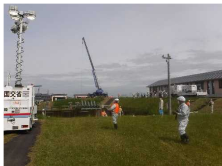
照明車設営訓練
