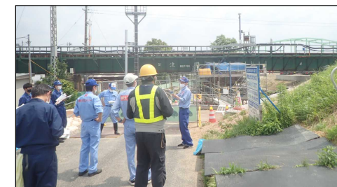
阿賀野市下里（羽越本線鉄橋）
