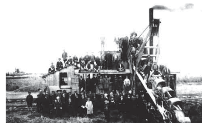
第一期改修時の掘削作業に活躍したエキスカベレーター
