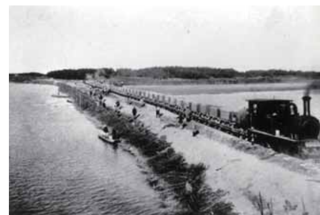
第一期改修時の最新式の蒸気運搬車
