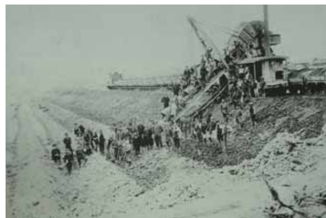
満願寺地内の工事風景(大正7年5月撮影)
