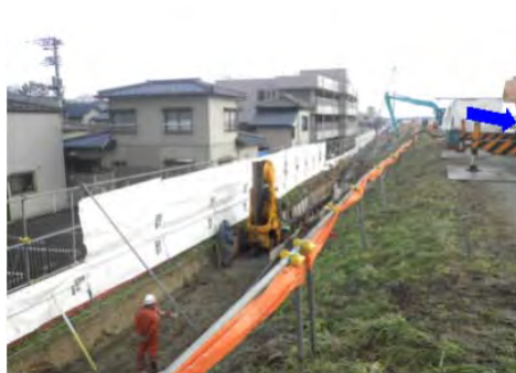
防音シートの設置
