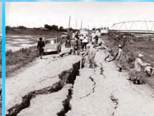
阿賀野川(新潟市東区下山地先)(S39新潟地震)
