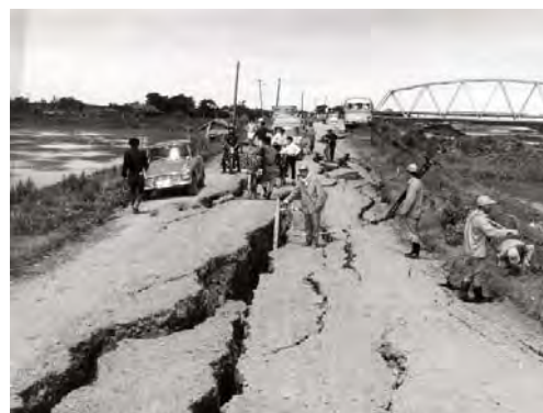
②堤防の亀裂と陥没 (左岸1.0k付近:新潟市東区下山)
