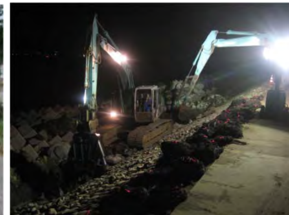
空域制限回避の夜間施工（新潟空港）
