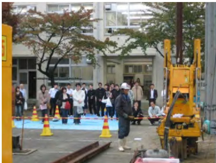
高校文化祭での鋼矢板圧入工法の実演
