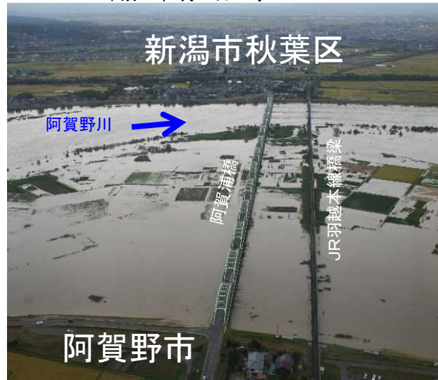
阿賀浦橋、JR羽越本線橋梁の出水状況 (新潟市秋葉区中新田地先) 平成27年9月10日13時
