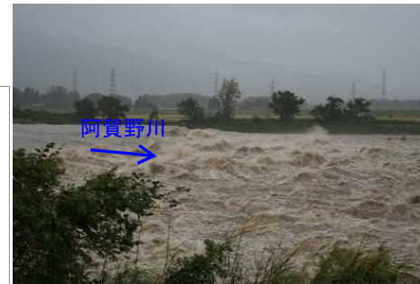
渡場床固工の出水状況 平成27年9月10日16時
