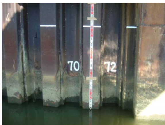
平常水位時には水面直下部となる部分の腐食状況
