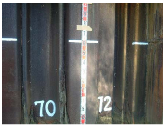
平常水位時には水面直下部となる部分の腐食状況
