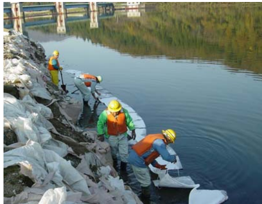
吸着マットによる油回収状況
