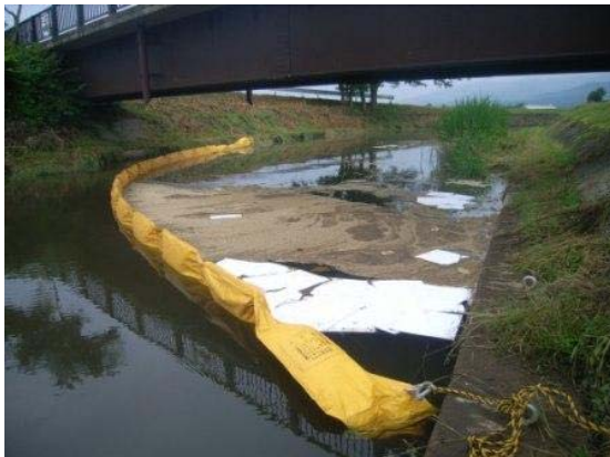
オイルフェンスによる下流への流出防止
