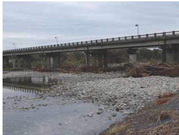
写真 流木の橋脚への堆積（平成16年洪水）（阿賀川）※1
