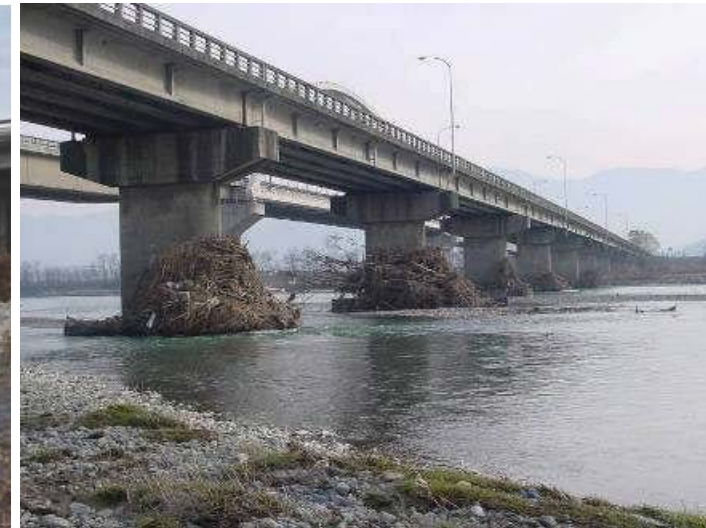
写真 流木の橋脚への堆積（平成16年洪水）（千曲川）※2
