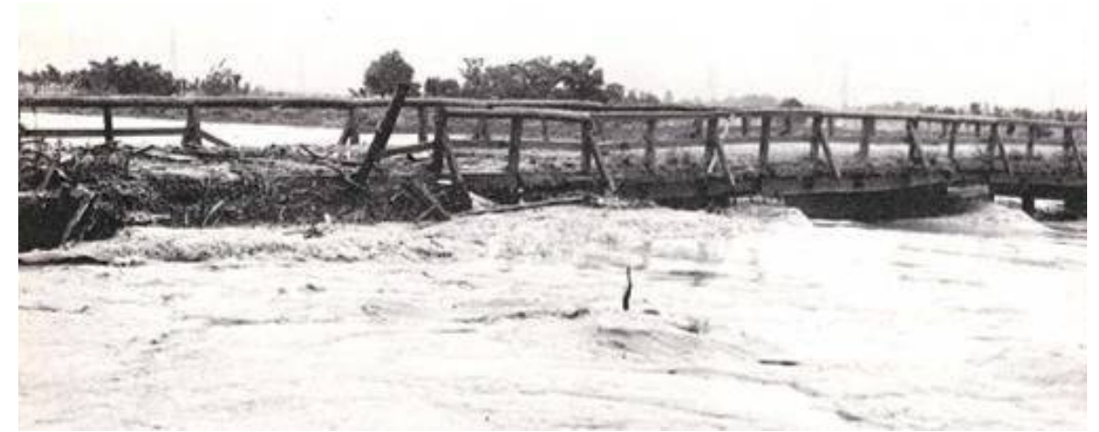
写真 早出川 昭和42年8月洪水※2
