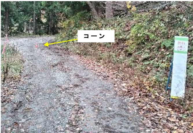
図 5-5 看板及びコーン設置
