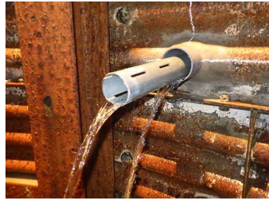
写真 5. 試験施工で使用したサビレス管 (堰沢 W-9 No.19 孔)
