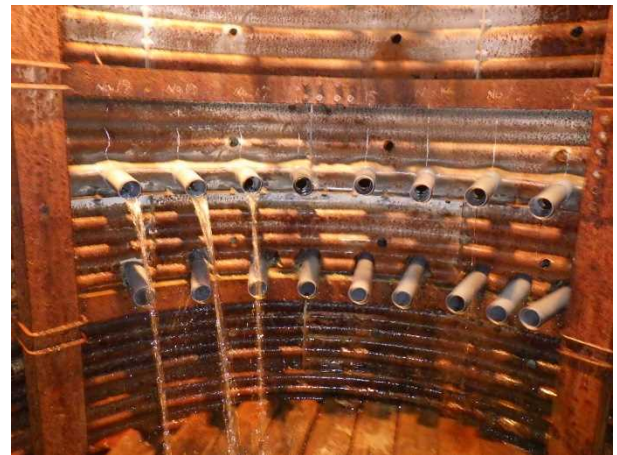
写真 6. 集水ボーリング工完成写真 (堰沢 W-9 No.12~No.19 孔)
