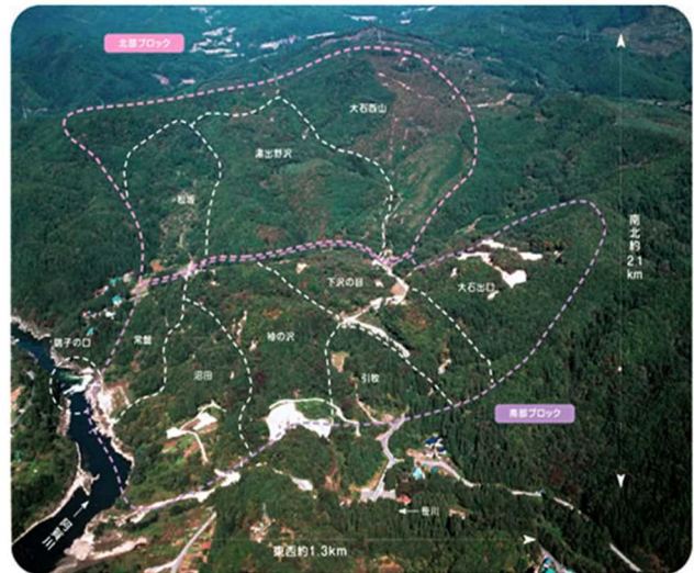
写真 1. 滝坂地すべり全体写真
